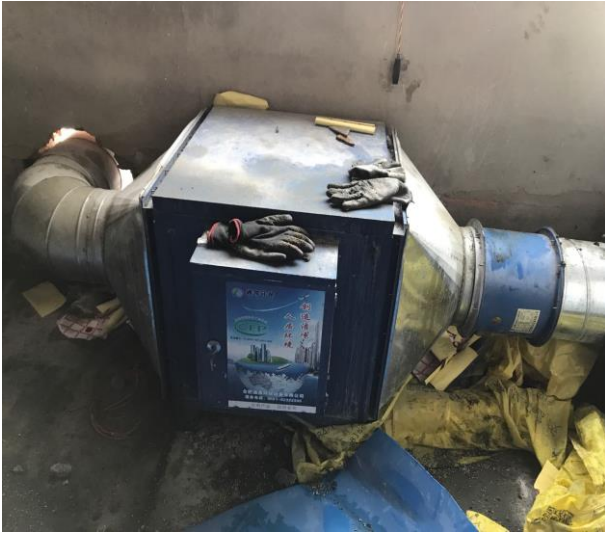
发泡成型工序现有二级活性炭吸附装置
