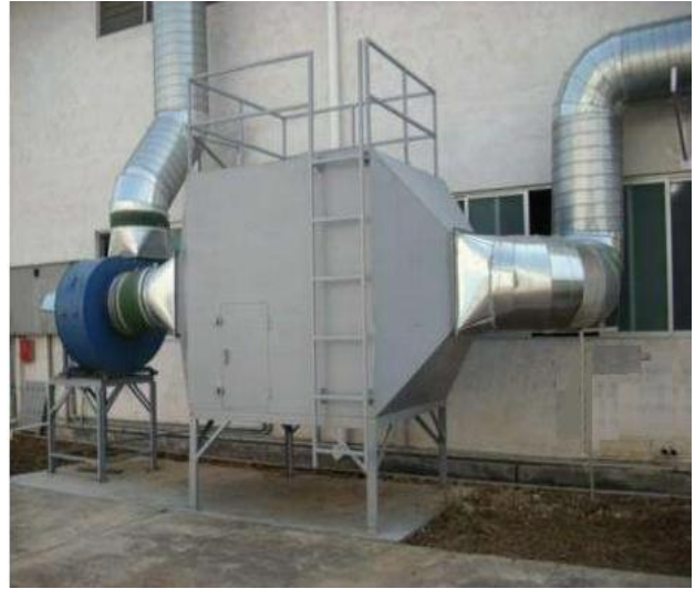
喷胶复合工序二级活性炭吸附装置
