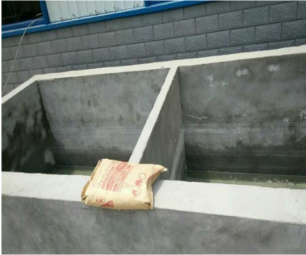
一体化污水处理设施
