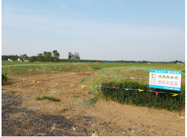
施工土方存放
