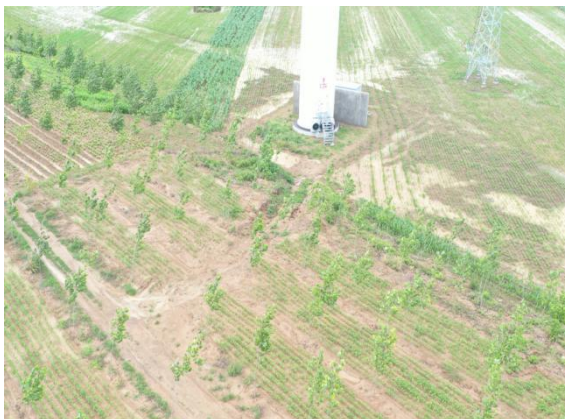
F7 号风机永久占地植被恢复和临时占地复耕情况
