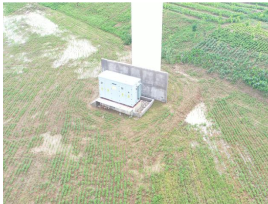
F6 号风机永久占地和临时占地复耕情况
