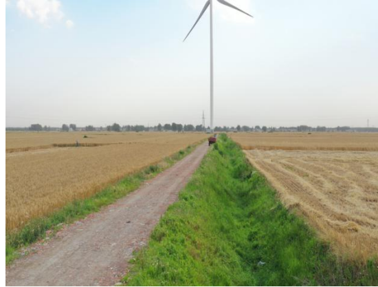
场内道路一侧排水沟措施
