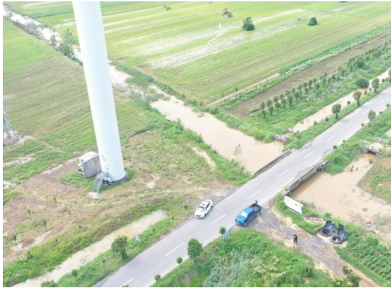
F9 号风机永久占地植被恢复和临时占地复耕情况
