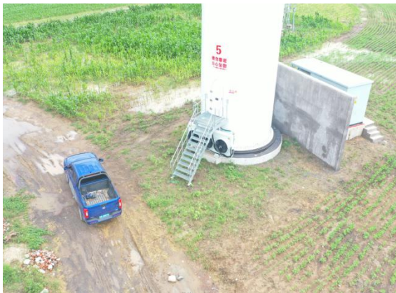
F5 号风机永久占地植被恢复和临时占地复耕情况
