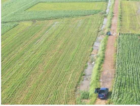
场内道路一侧排水沟措施及植被恢复措施
