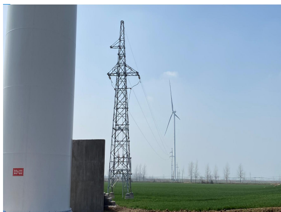
集电线路植被恢复情况
