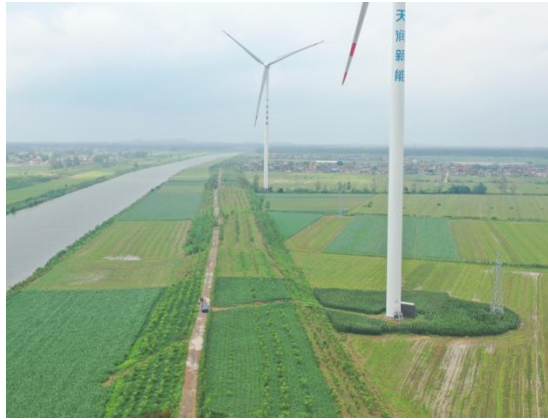
F2 号风机永久占地植被恢复和临时占地复耕情况
