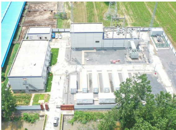
升压站区植被恢复情况
