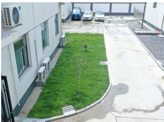
升压站内植被种植情况
