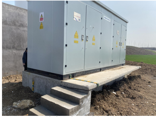
风机机组变压器密闭隔声
