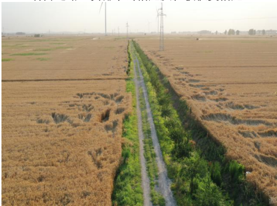
场内道路一侧排水沟措施
