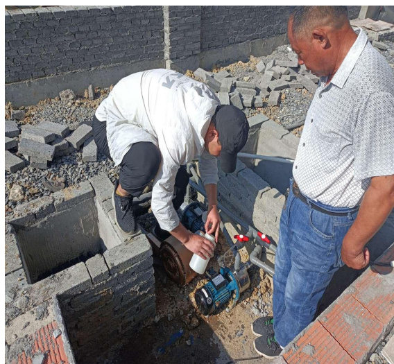
生活污水采样装置
