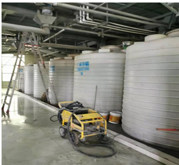
外加剂储罐围堰
