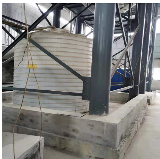
外加剂储罐围堰
