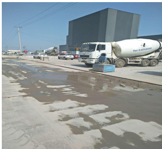
厂区雾炮装置
