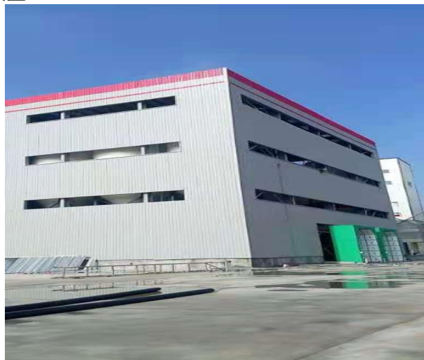
搅拌楼密闭（筒仓设置脉冲式仓顶除尘器）
