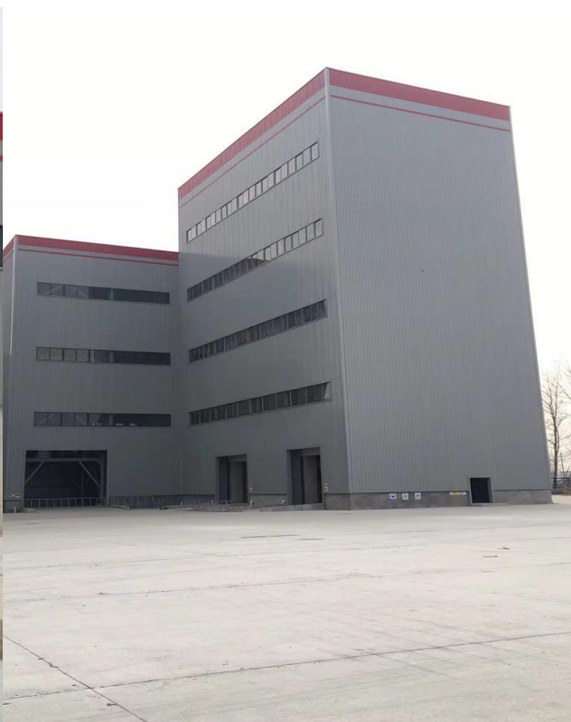
搅拌楼密闭（筒仓设置脉冲式仓顶除尘器）
