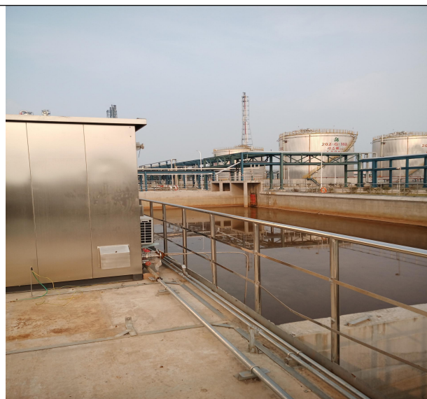
初期雨水收集池
