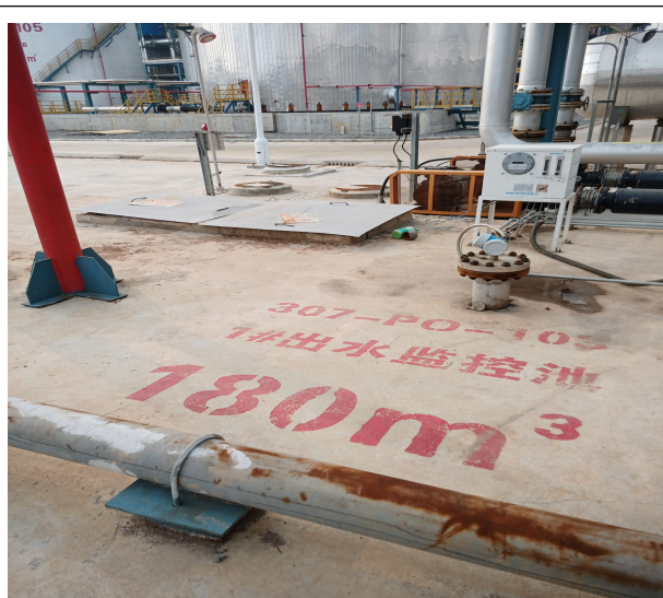
污水外排监控池
