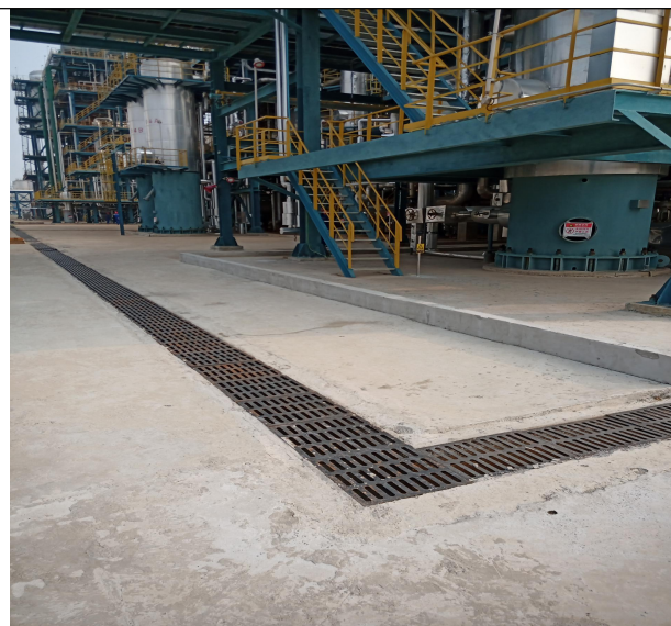
乙烯装置区导流沟
