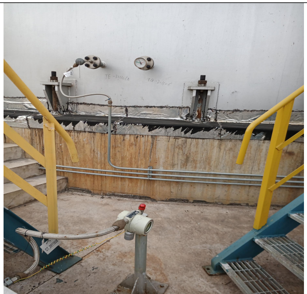
中间罐区围堰
