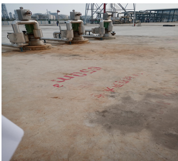
一期污水处理设施
