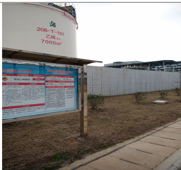
低温乙烯罐区围堰
