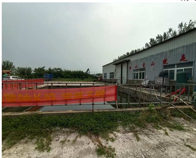
循环冷却水池
