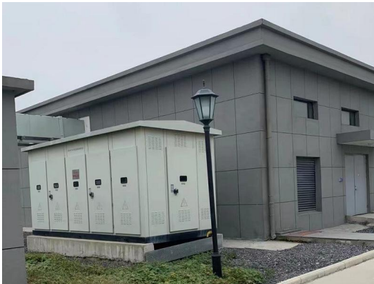
升压站站用变氟气密闭隔声
