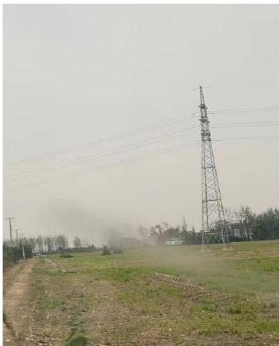
集电线路植被恢复情况
