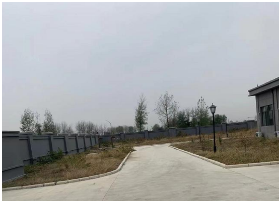
升压站区植被恢复情况
