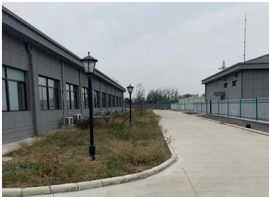
升压站内植被种植情况
