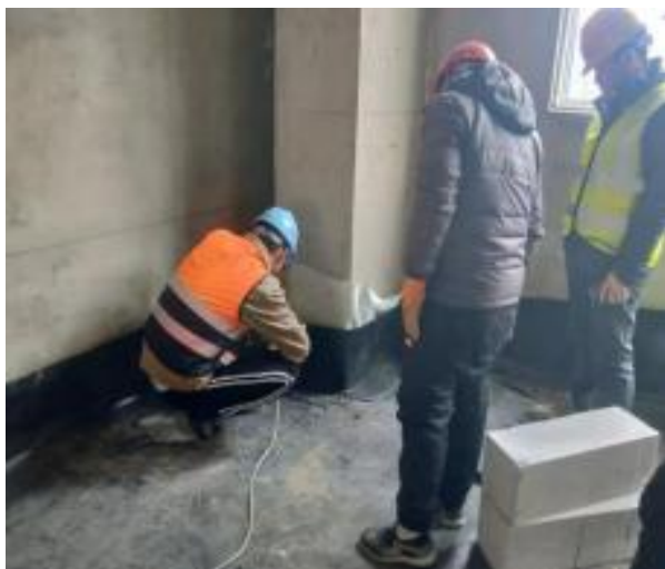
乙类危废库防渗施工照片
