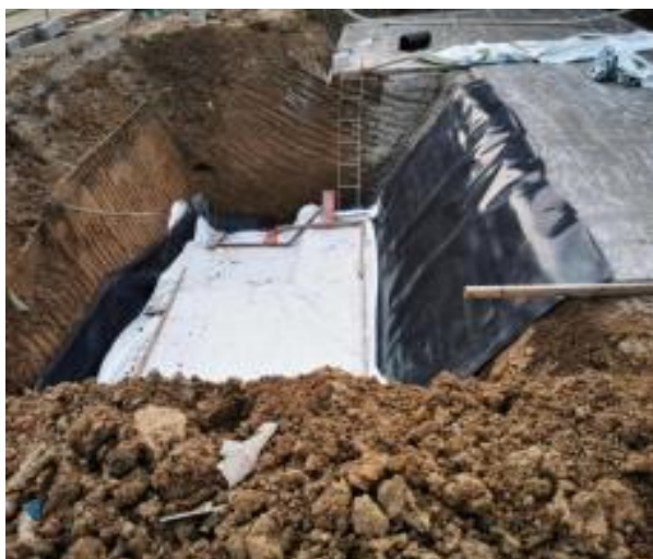
污水处理站防渗施工照片
