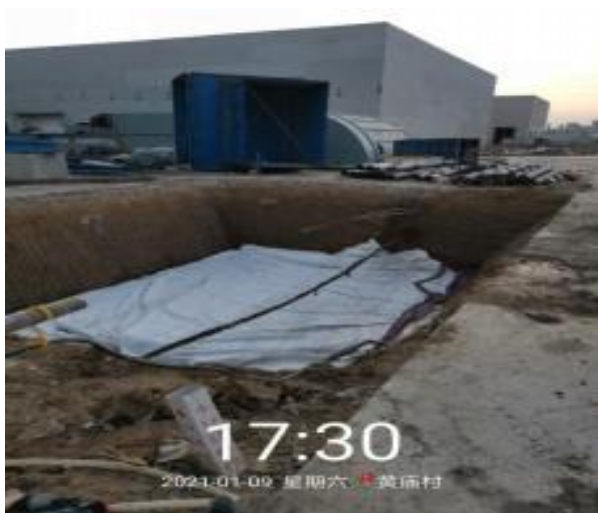
焚烧线初期雨水池防渗施工照片
