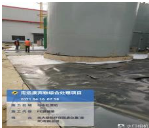
污水处理站防渗施工照片
