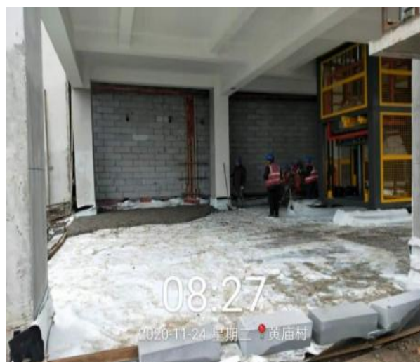
焚烧车间防渗施工照片
