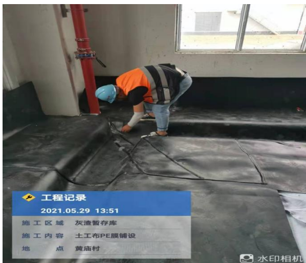
灰渣库防渗施工照片
