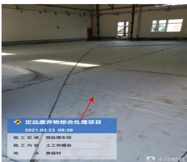
预处理车间防渗施工照片
