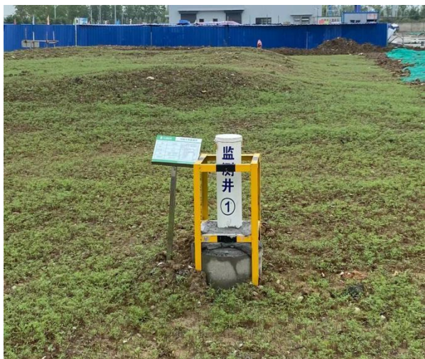
地下水监测井 1
