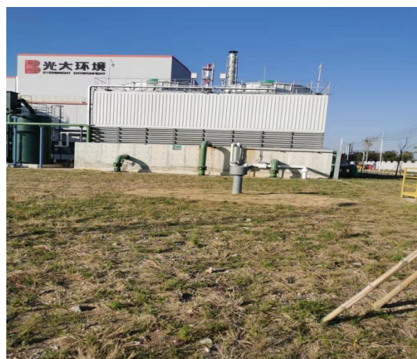
初期雨水收集池
