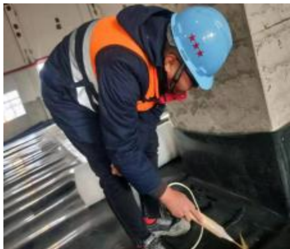
丙类危废库防渗施工照片
