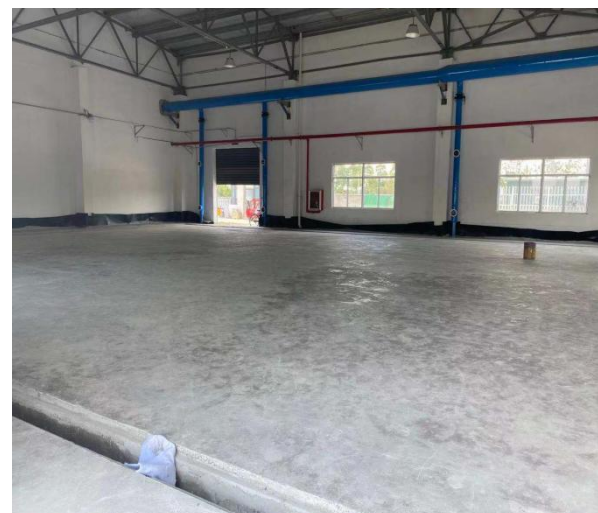
灰渣库防渗施工照片
