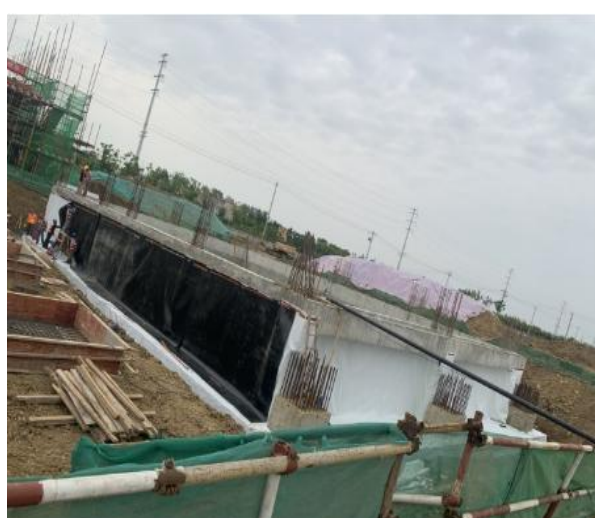
焚烧坑防渗施工照片
