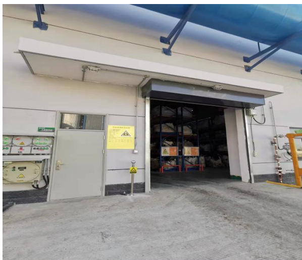
危险废物仓库
