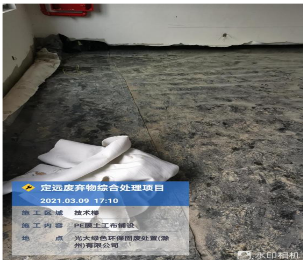
技术楼药剂间防渗施工照
