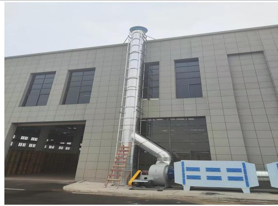
喷漆工序：二级活性炭吸附装置+15m 高排气筒
