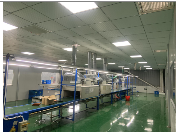
印刷工序废气收集
